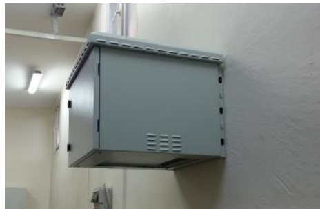
Postavljanje na zid
