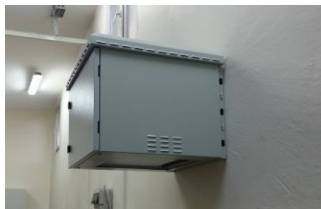
Postavljanje na zid
