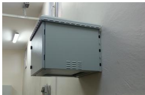
Postavljanje na zid
